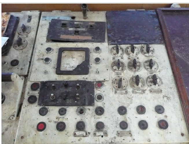
Фотография 3.23. Внутренние помещения Объекта оценки (рубка)
